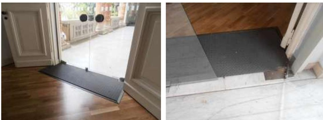
**Figura 275 e 276 – Rampas metálicas nas portas de acesso às varandas. 2011.**
